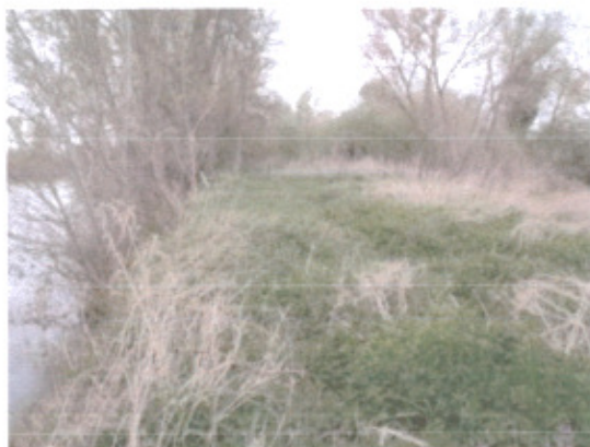
Rive haute à l'amont de l'ancien bras
